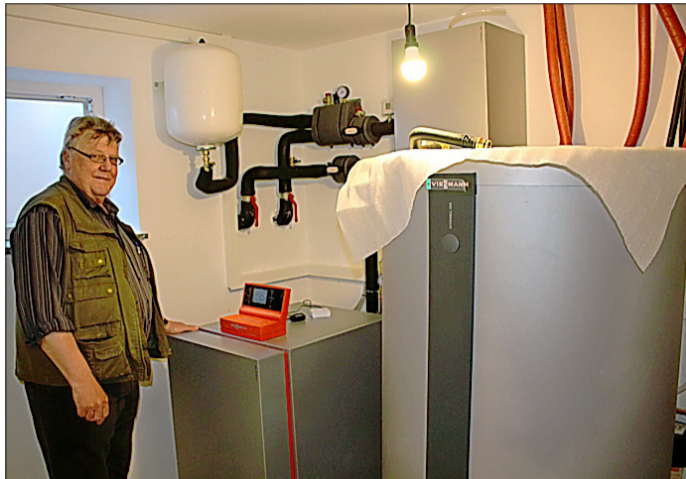
Hans Trilse präsentiert die hochmoderne Heiztechnik des Hauses im Neubaugebiet oberhalb von Großseelheim.
